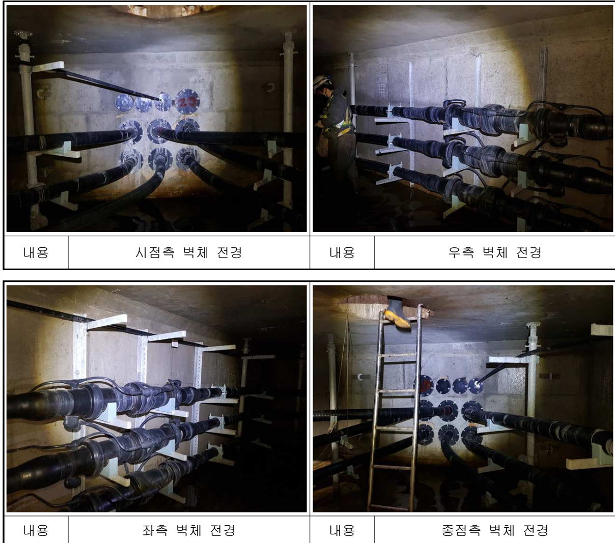
【사진 5.9】 신덕은~문산 #3 전경
