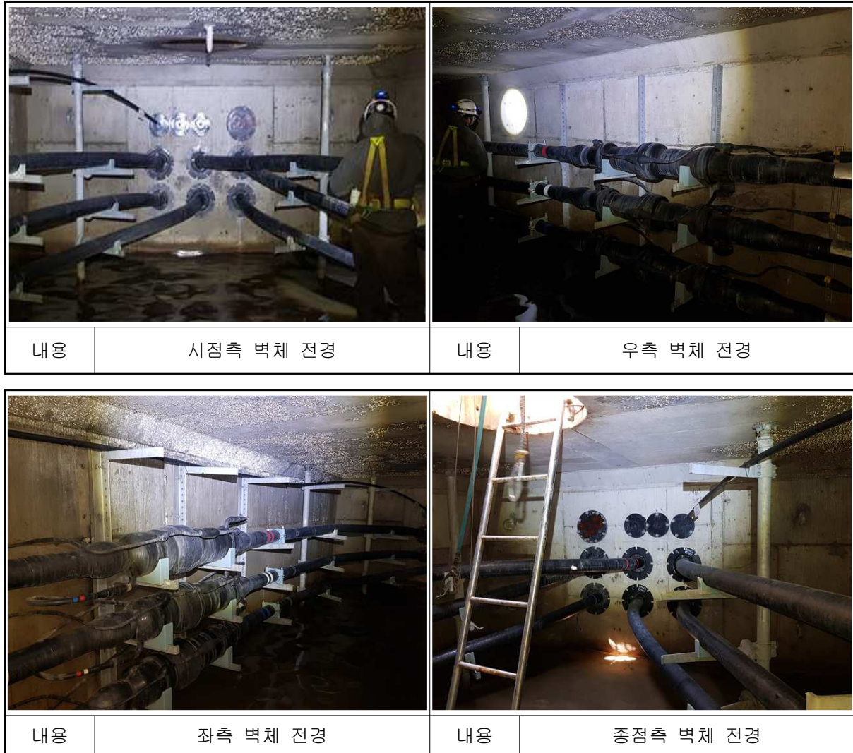
【사진 5.13】 신덕은~문산 #4 전경
