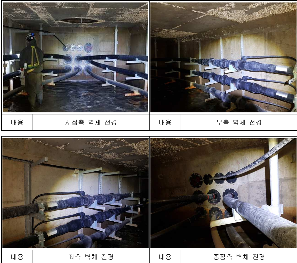
【사진 5.5】 신덕은~문산 #2 전경
